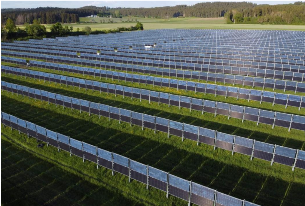
Beispiel einer bifazialen Agri-Photovoltaikanlage (Foto: Next2Sun).
